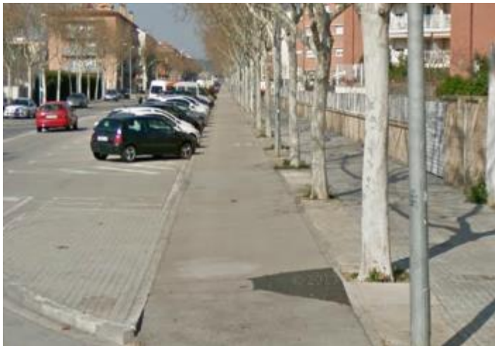
Figura 22. Carril segregat en vorera a la Ronda Santa Eulàlia
