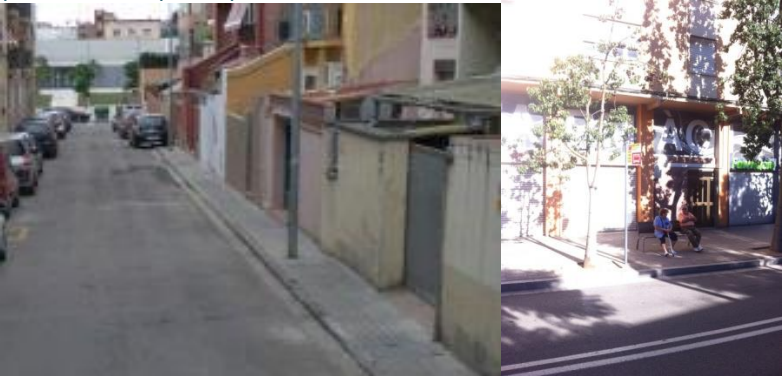
Figura 17. Imatge del carrer Goya Pintor amb una amplada lliure de pas inferior a 0,9m. A la dreta imatge de l'avinguda Prat de la Riba amb una amplada lliure de pas superior als 2,5m.
