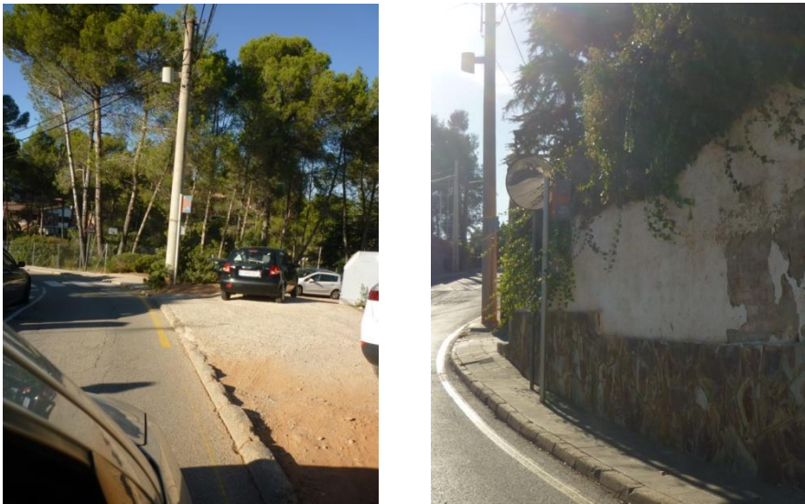
Figura 26. A l'esquerra parada de bus urbà a Fontpineda (Via Abadia de Poblet) amb barreres arquitectòniques. A la dreta parada de bus urbà a Fontpineda (Via Italiana) amb barreres arquitectòniques.
